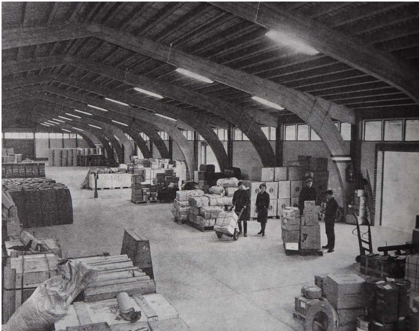
Valokuva 1960-luvun alussa valmistuneesta Kaukokiidon terminaalista. Kuvassa näkyvä varastohallin osa on purettu 1990-luvun alussa tontille rakennetun uudisrakennuksen tieltä. Kuva: Kaukokiito-lehti 3/1964
