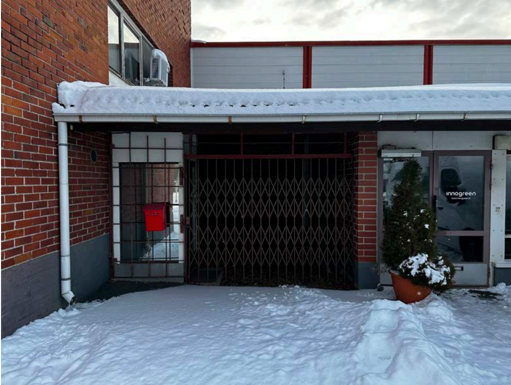
1980-luvun laajennuksen sisäänkäynnit lännen suunnasta kuvattuna.
