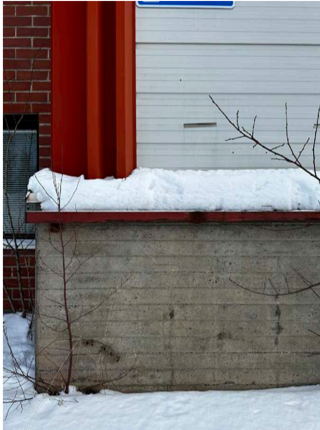
Ote 1980-luvun laajennuksen muovipinnoitetusta profiilipeltijulkisivusta ja vaakalautamuottipintaisesta betonisokkelista etelän suunnasta kuvattuna. Profiilipeltien värit RR 17 maalarin valkoinen ja RR 7 tiilenpunainen.
