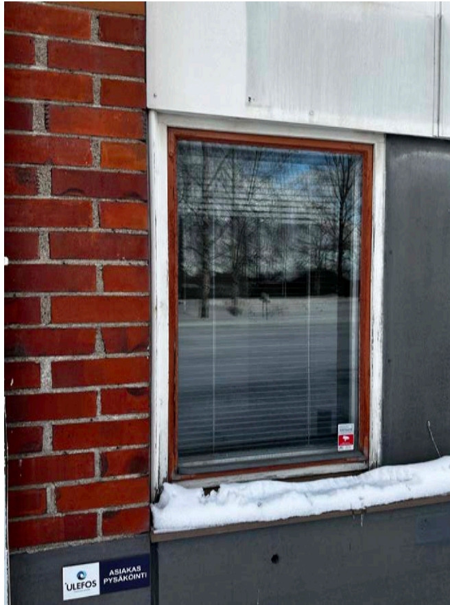
Länsijulkisivun ikkuna toimisto-osalla.
