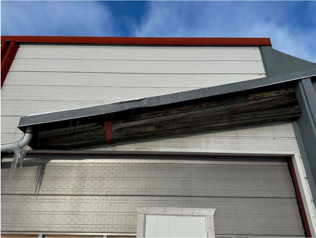
Laajennusosan ja alkuperäisen varastohallin vesikattoliittymä itäjulkisivulla.
