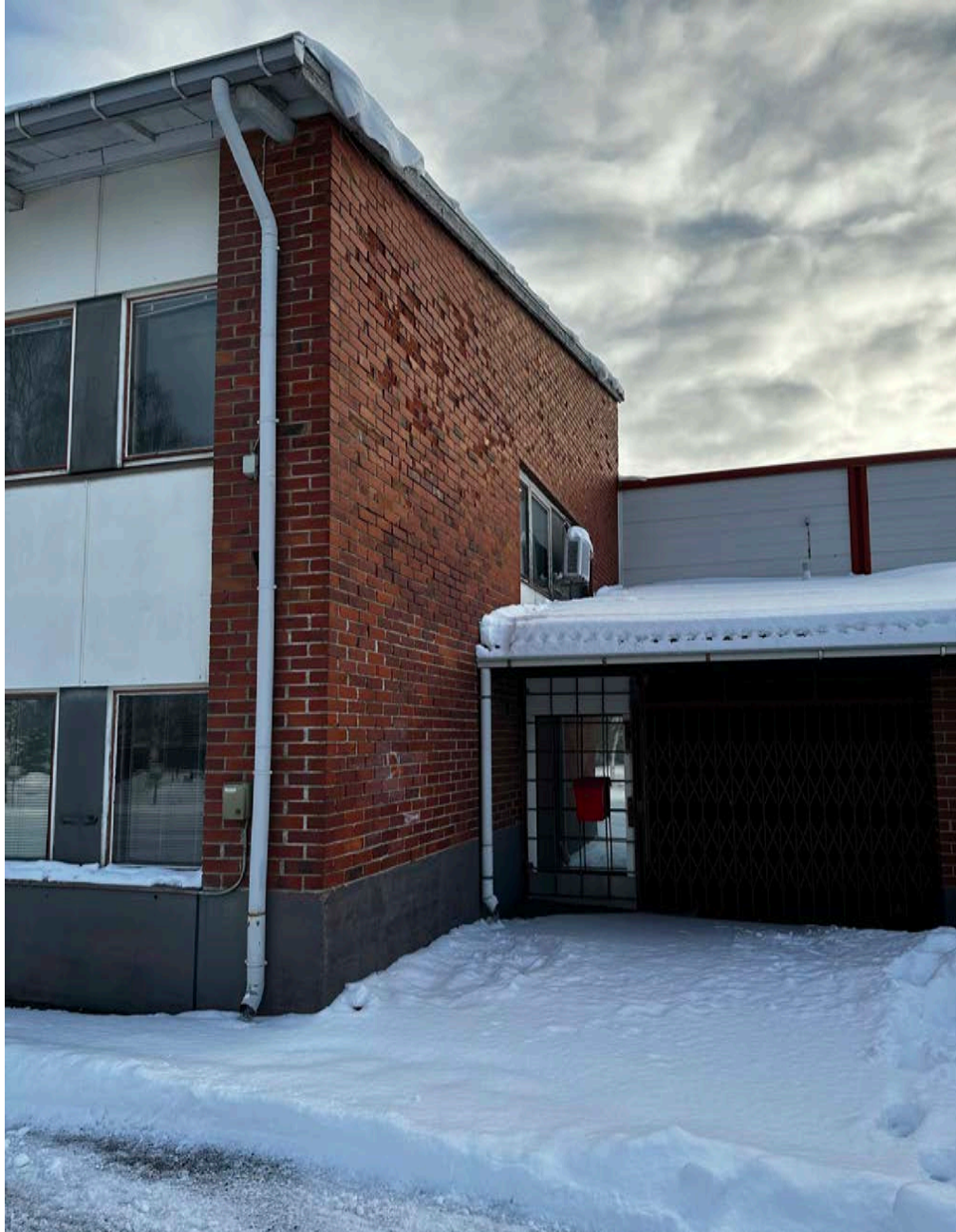
Alkuperäisen toimisto-osan ja 1980-luvun laajennuksen välinen rajapinta.
