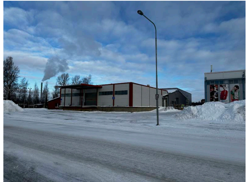
Katunäkymä Vihiojantieltä. Alkuperäisestä puretusta varasto-osasta on nähtävillä harjakattoinen pääty, joka on ummistettu tumman harmaalla profiilipellillä.
