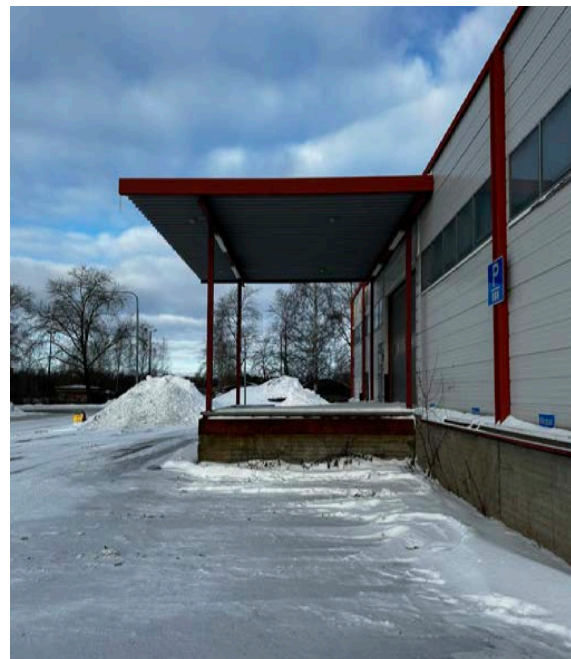
1980-luvun laajennusosan lastauslaituri idän suunnasta kuvattuna.
