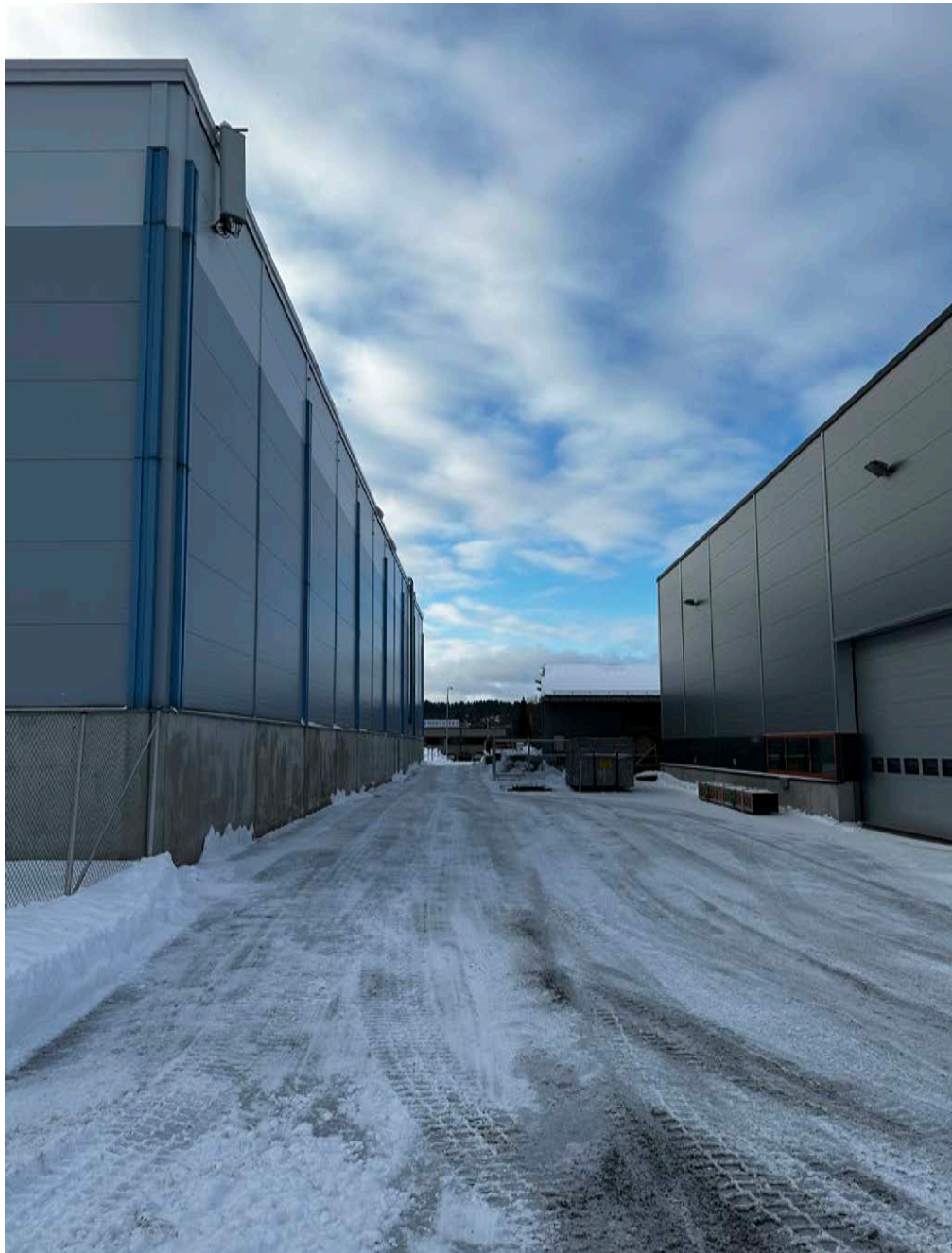
Näkymä tontin pohjoisosasta kuvattuna etelän suuntaan. Osa jäljellä olevasta lastauslaiturista.
